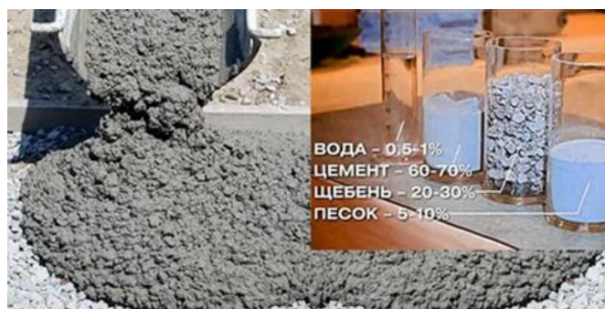
Рисунок 1- Бетонная смесь стандартного состава для строительства
