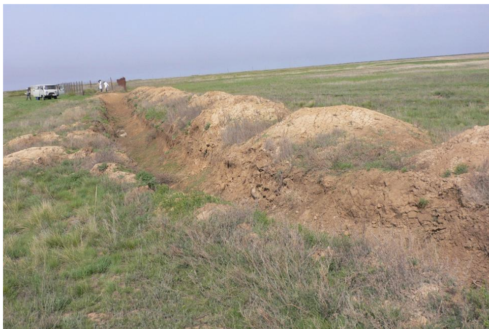
Рисунок 9 – Траншея после извлечения электрокабеля
