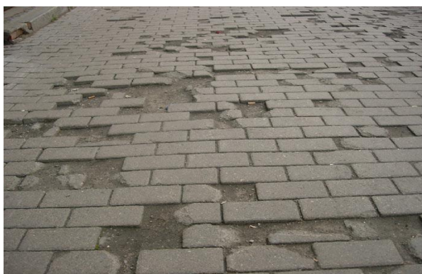
Сурет-1. Цементті-бетон материалдардан жасалған жол төсеніштерінің бұзылысқа ұшырауы
