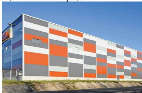
Сурет 2 - қабырғалық сэндвич-панельдерден салынған өнеркәсіптік ғимарат
