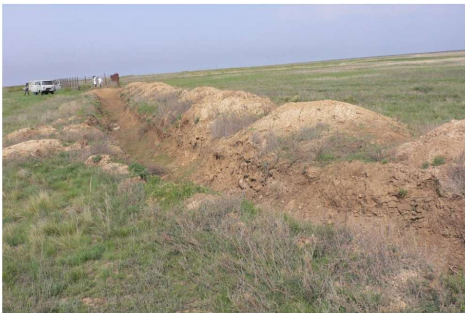
Рисунок 9 – Траншея после извлечения электрокабеля
