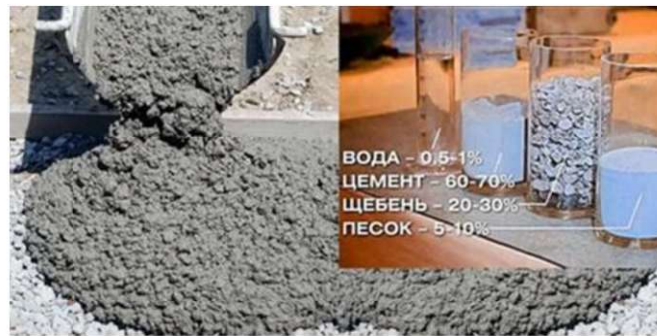
Рисунок 1- Бетонная смесь стандартного состава для строительства
